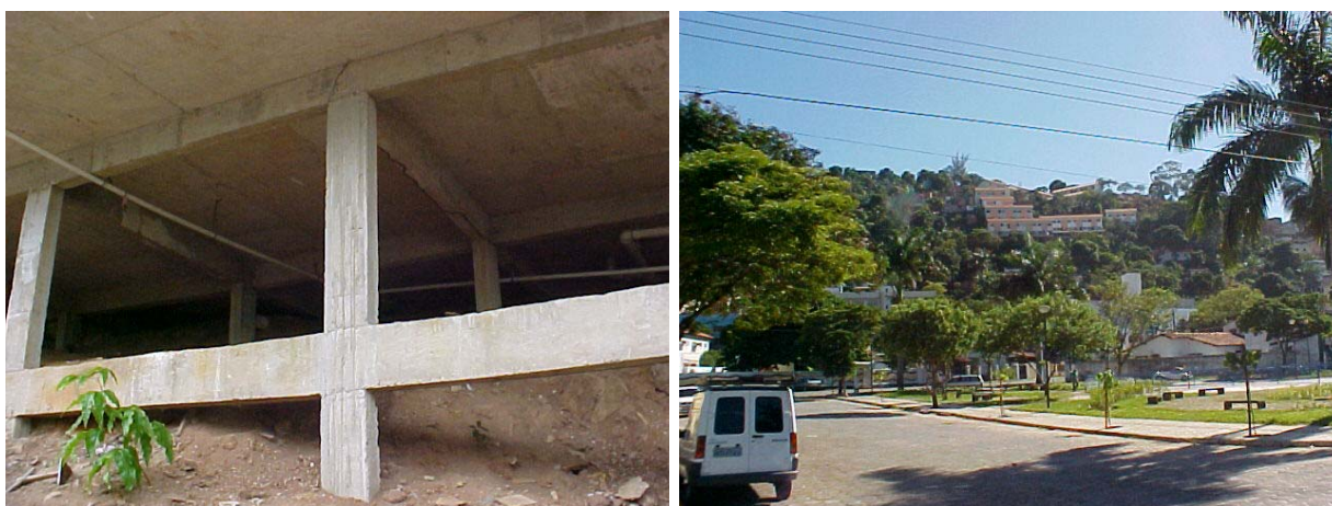
Figura 3 – As construções implantadas em áreas de declividade acentuada apresentaram grandes alturas em seus “pilotis”, como observa-se à esquerda. A ociosidade dessas áreas pode resultar em uma ocupação clandestina. À direita, vista dos conjuntos de habitações implantados no bairro. Fonte: LPP/UFES (2002).
