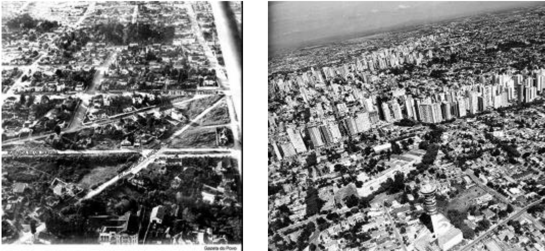
Fig.2/3–vista de Água Verde (1958) e mais recente mostrando as Estruturais
