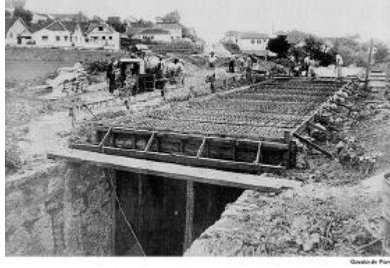
Fig.17 -Canalização do Rio Água Verde em 1952.
